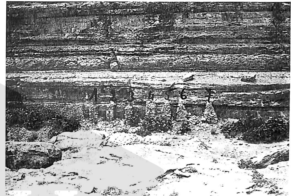
FIG. 16. — Haute vallée de l'oued Bedjer: lieu-dit Boucharoui. Aqueduc dont les piles sont les unes en pierres sèches, les autres composées pour partie de matériaux antiques. Vers la droite, à partir de la pile 4, on aperçoit les mortaises marquant le tracé de la conduite antique. Au-dessus, falaise de l'oued Bedjer.
